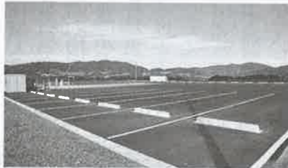
広い作業スペースが確保されている「コネクティア浜松」
